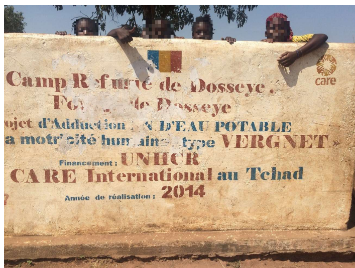
Photographie 13 – Equipement hydraulique, Camp de Dosseye, Région du Logone Oriental, 28 novembre 2017
